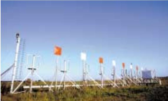
Vue d'un localiser définissant, par des moyens radioélectriques reçus par le pilote, le plan vertical passant par l'axe d'une piste
