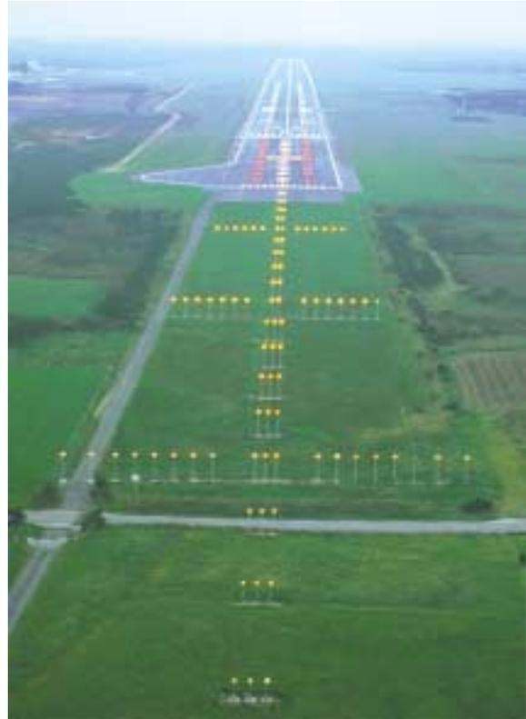
Vue d'une ligne d'approche de précision de CAT II-III avec un seuil décalé
